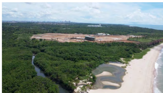
Figura 5. Construção do Tauá Resort
